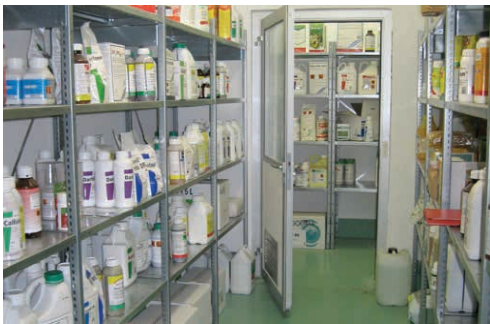
Lager für umweltgefährdende und giftige Stoffe: separater Brandabschnitt mit Lüftung und mediumbeständigem Boden.
